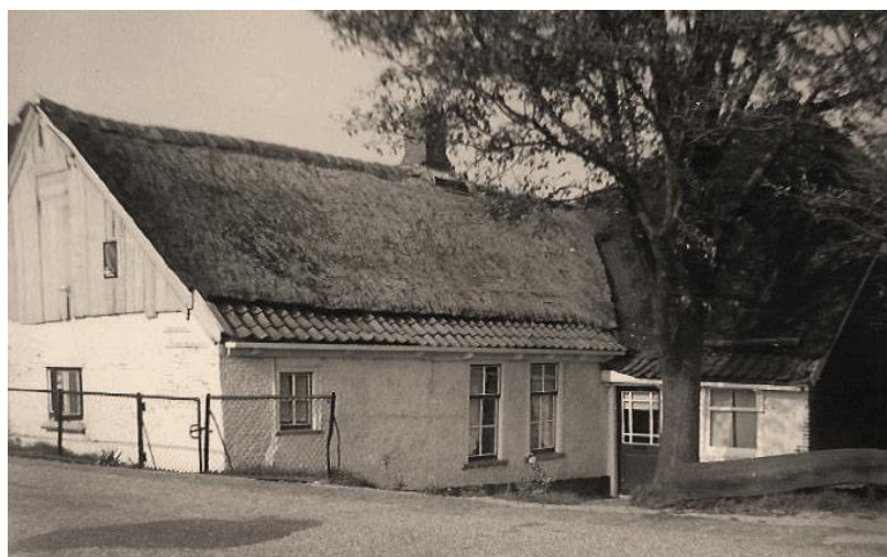
Kanaaldijk 28, brandstoffenhandel Lugtigheid
