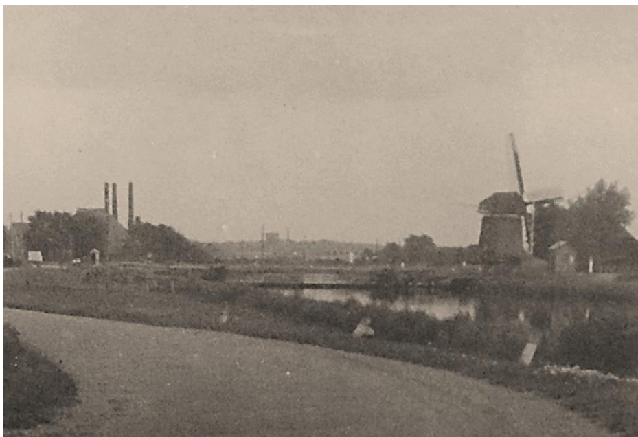
De vlotbrug met op de achtergrond de schoorstenen van de kalkbranderij
